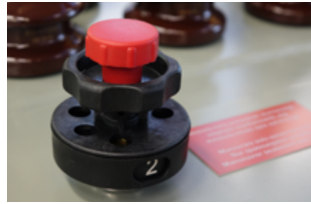
Abb. 12: Spannungsumsteller
