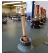
Abb. 17: Niveauekontrolle (freiatmend)
