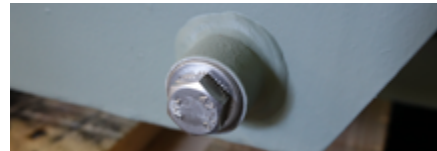
Abb. 13: Erdanschluss (Kessel)
