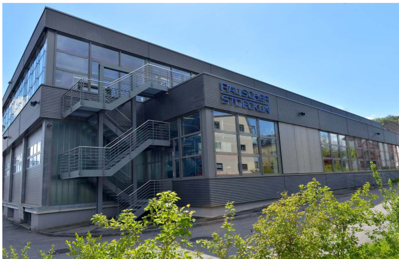
Notre site de production à Sissach
